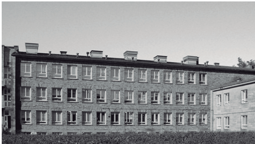
Fig. 6. Fachada trasera del IIA. Fotografía: CSIC.
