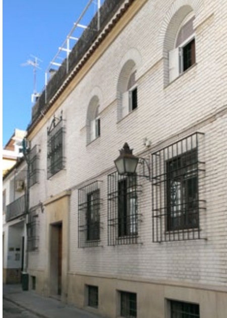
Fachada de Sandoval
