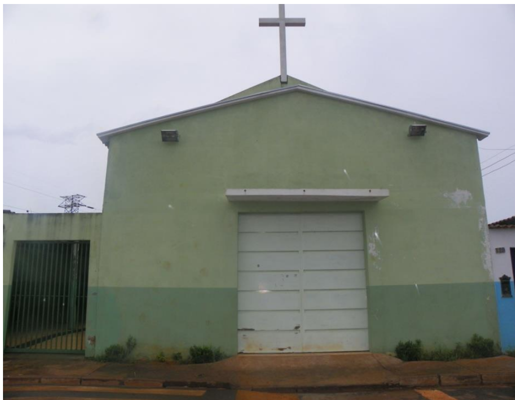
Imagem 8 - Paróquia Santo Antônio no Bairro Morumbi. 2019. Fonte: BARRA, V.S, 2019.
