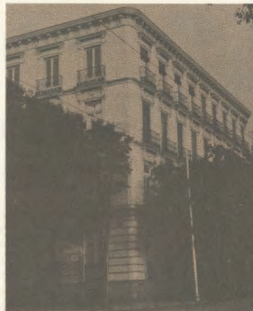
Neste edifício da Rua Ferraz, n.50 (Madri), a partir de outubro de 1934, a Residência DYA ocupou dois apartamentos no penúltimo andar; a Academia estava em um outro apartamento do último andar.
