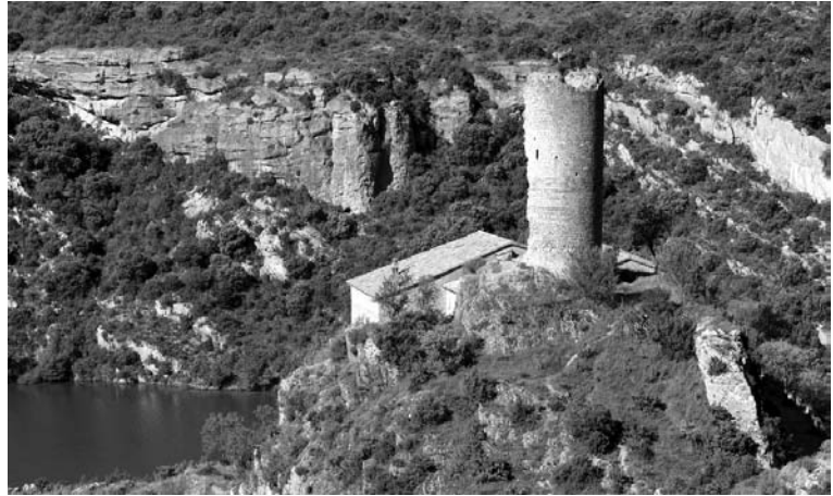
Antigua ermita de Torreciudad, con la torre defensiva.
