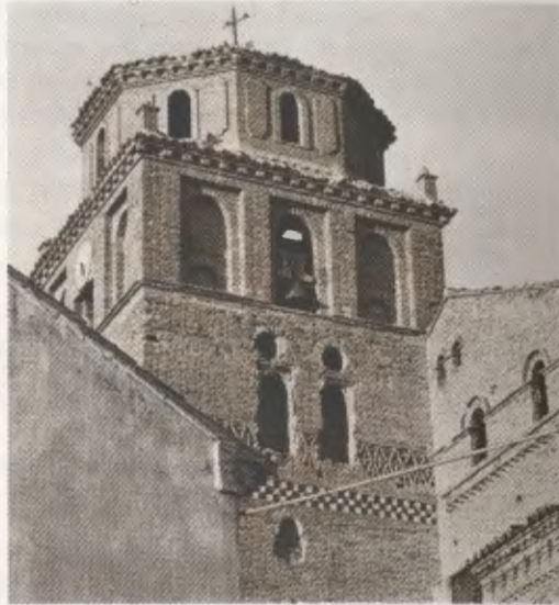
Vista de la torre de la iglesia de Perdiguera.
