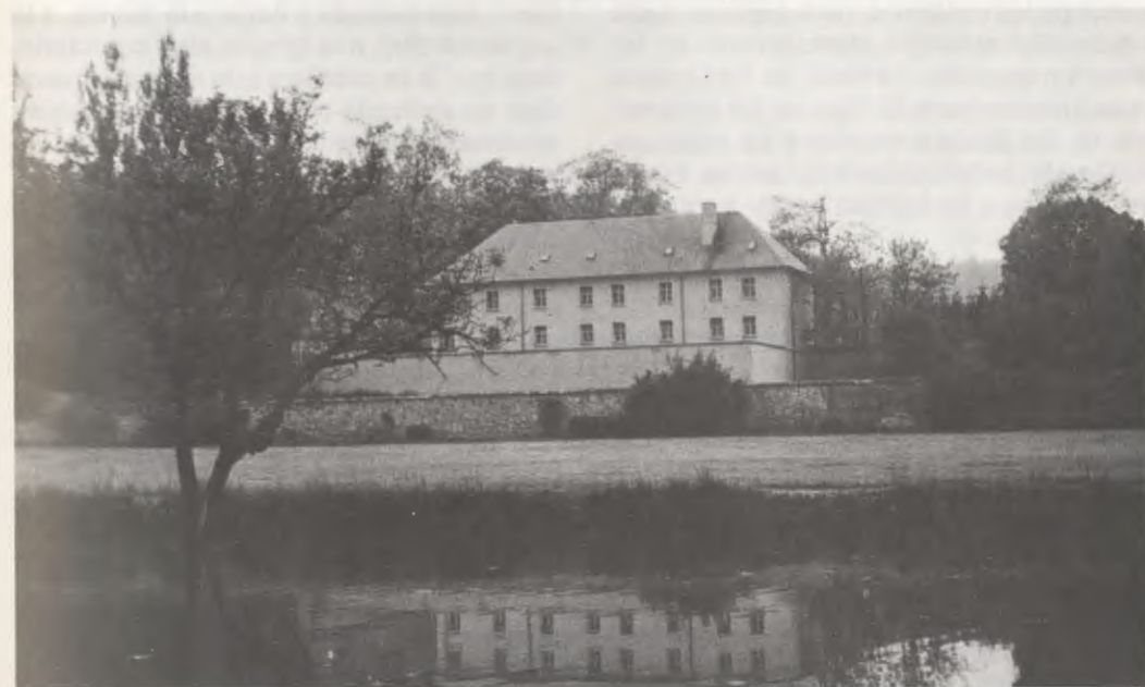
Vista de la fachada posterior de Dosnon , Escuela Hotelera en Couvrelles, cerca de París.
