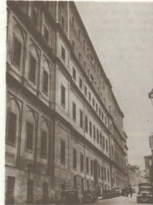
Façade de l'ancien Hôpital Général de Madrid dans les années 30. On aperçoit au fond l'église de la Fondation Sainte Isabelle, dont le Serviteur de Dieu fut le Recteur.
