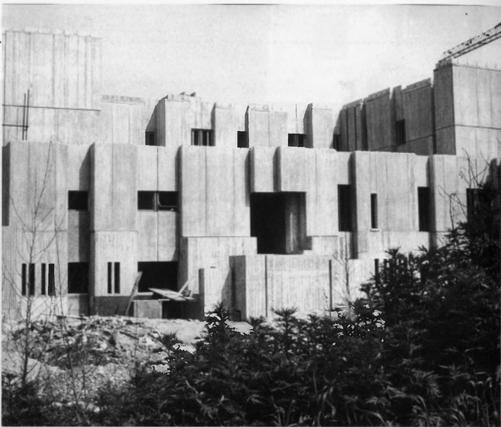
Una suggestiva immagine di Torrescalla in costruzione
