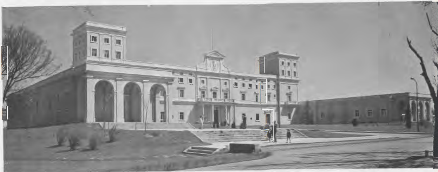
Edificio Central, sede de varias Facultades e Institutos de Humanidades.
