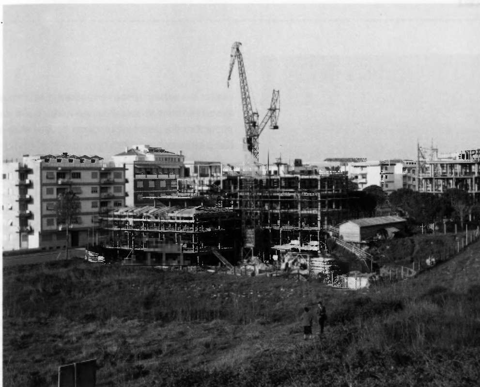
La RUI in costruzione nel luglio 1958
