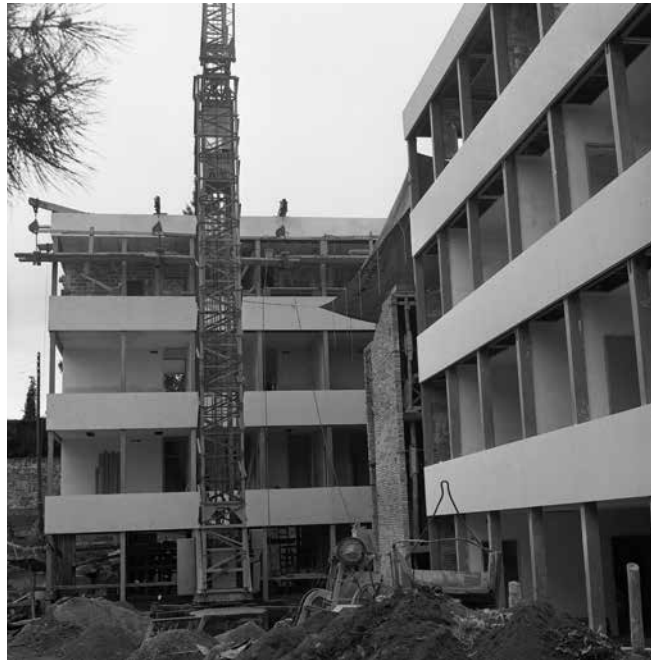
Construcción del edificio B (noviembre 1962).
