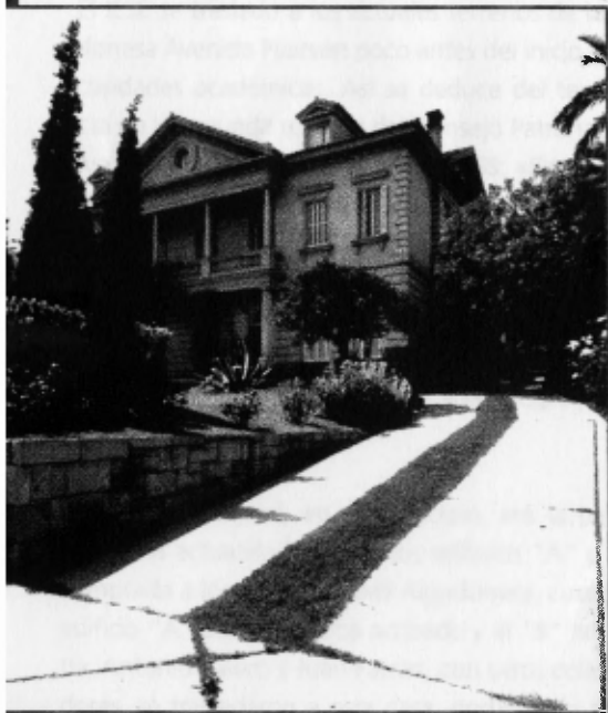
Edificio A en noviembre de 1958
