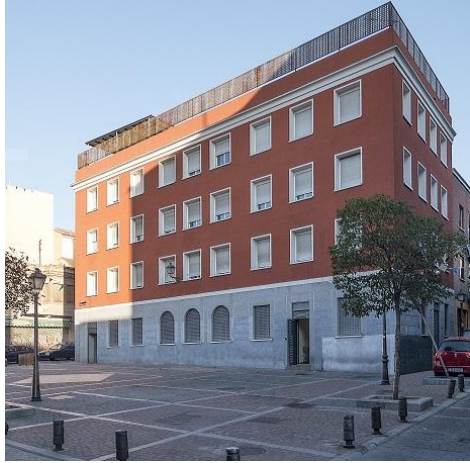
El colegio Luz Casanova, frente a la iglesia de San Ramón, tenía dos plantas. Posteriormente, se añadieron dos alturas más (Foto: Javier Berguizas).
