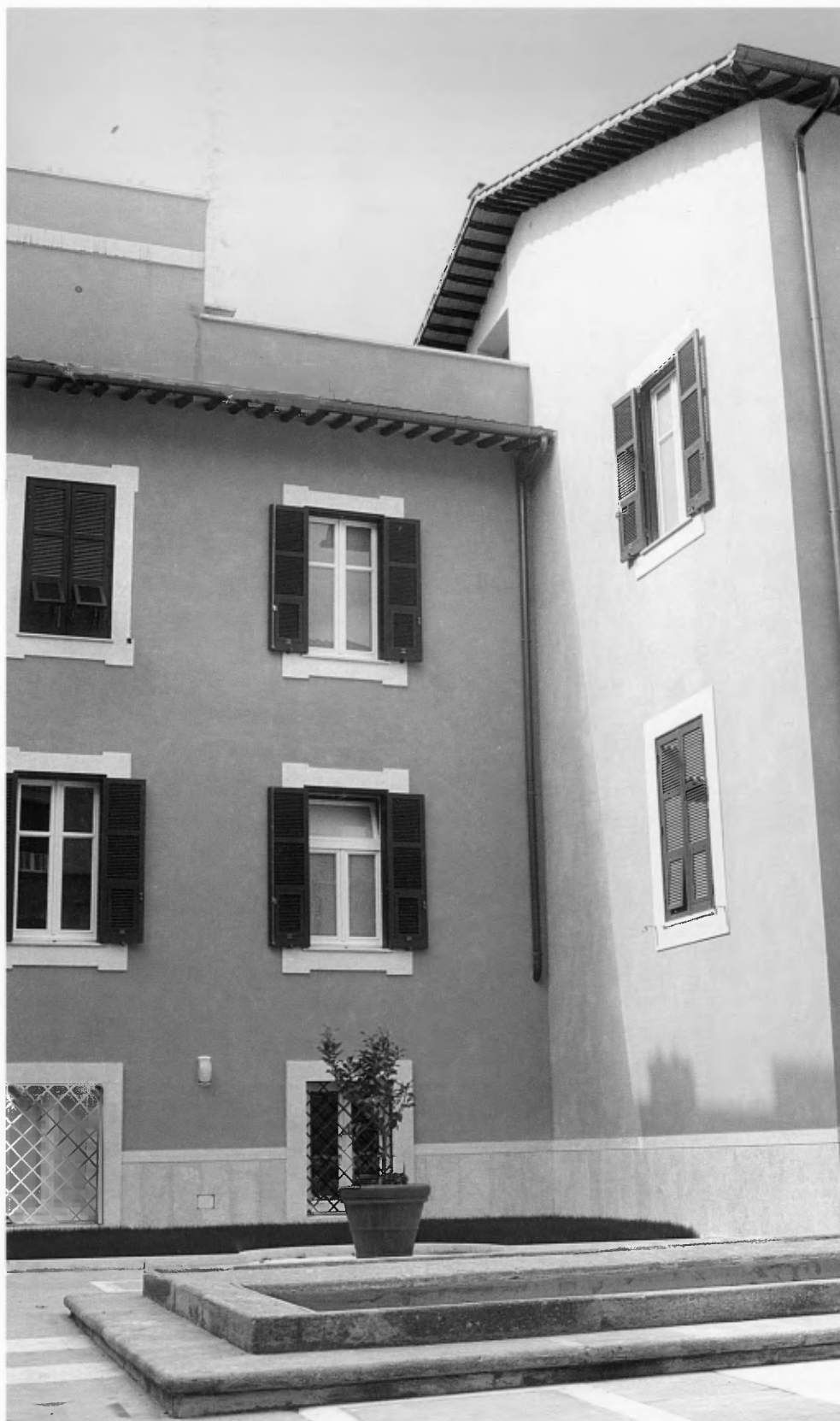
Particolare del cortile di Via dei Salumi con il lavatoio di recupero
