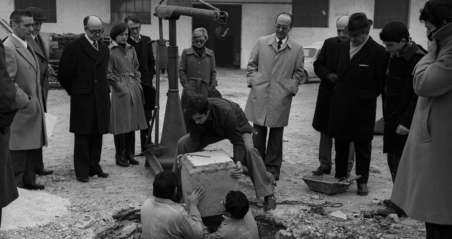
En la colocación de la primera piedra de la Escuela de Arquitectura, en 1975.
