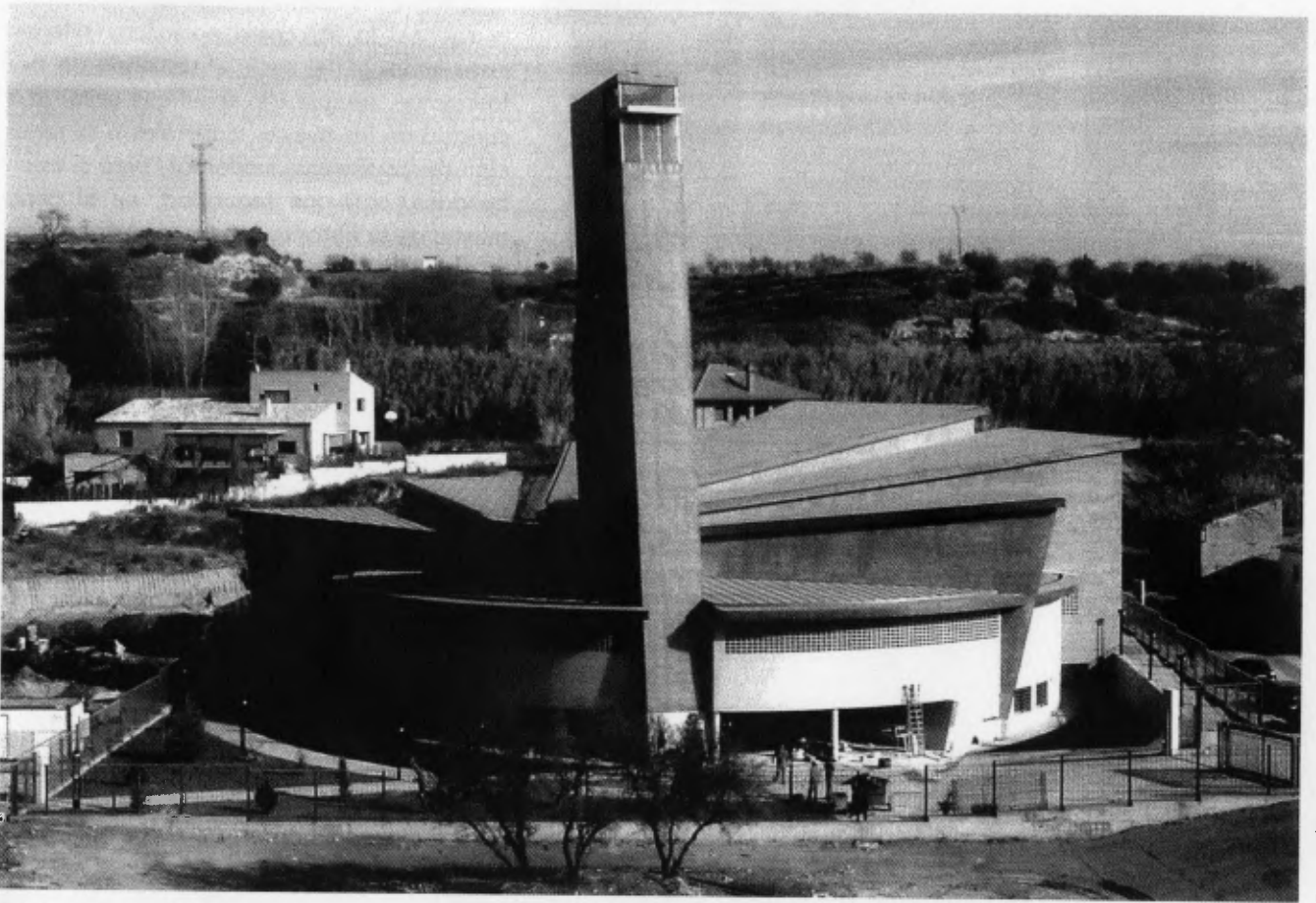
Exterior de la Iglesia.
