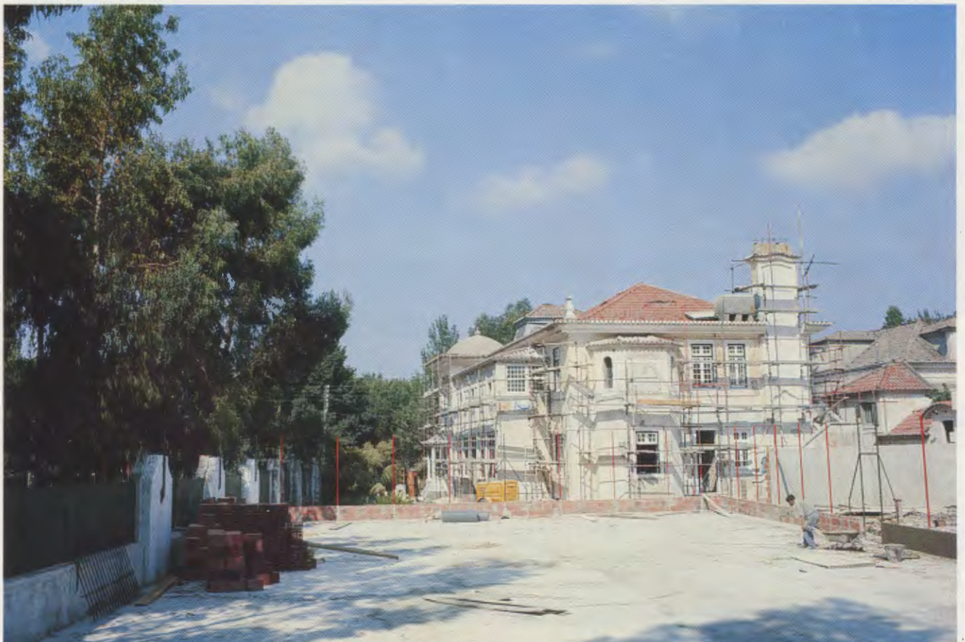
as obras no Xénon em 1972
