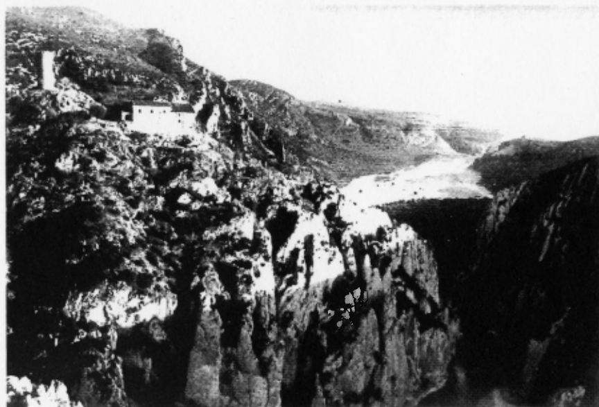
La ermita antes de la construcción del embalse.
