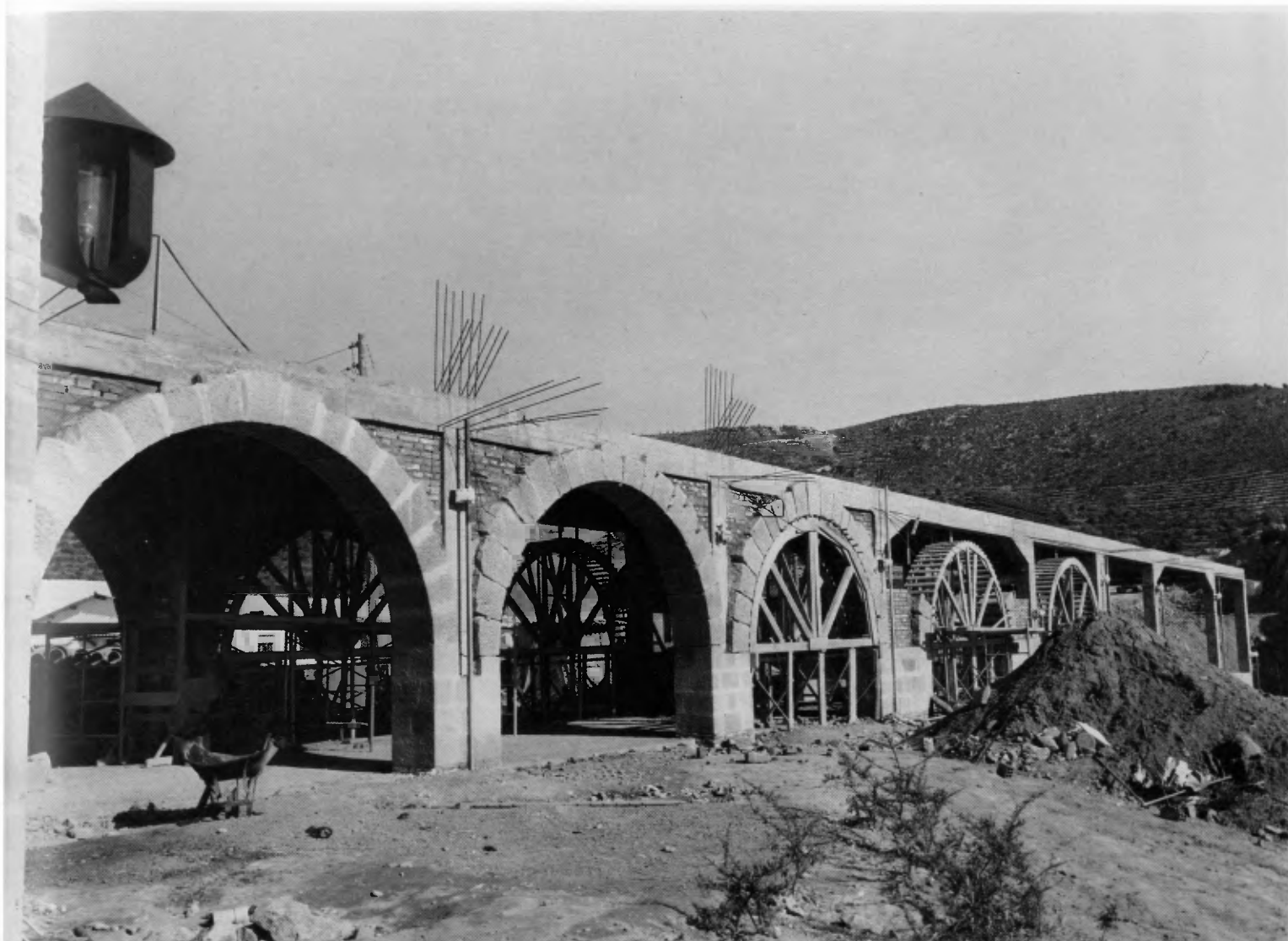
Las mismas cimbras que sirvieran para reconstruir los ocho arcos antiguos de la Plaza del Reloj se utilizaron para los nuevos de la explanada.
