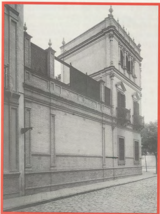
Aspecto de una de las fachadas de Canalejas 8, obra de arquitectura urbana no monumental de Aníbal González.
